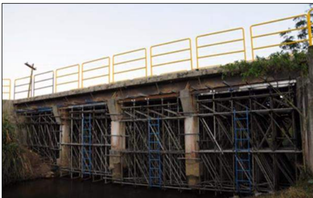
Figura 12.2: Reforço na Estrutura para Receber a Passagem de Excesso de Peso
